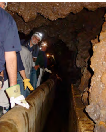
Fig. 25. Concrete channel, Furna d'Água, Terceira
