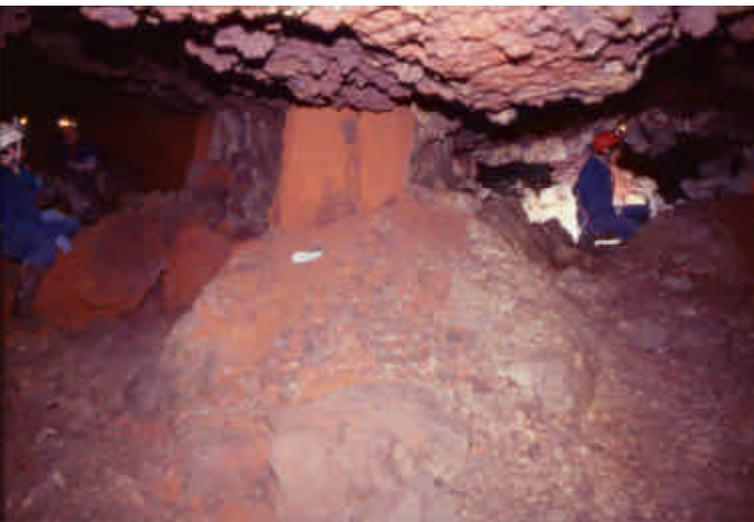
Fig. 8 - Cava Botte dell'Acqua. Esempio di pilastro residuale in ghiara accostato a materiale lavico parzialmente crollato sia dalle pareti che dalla volta. (Foto A. Marino).
