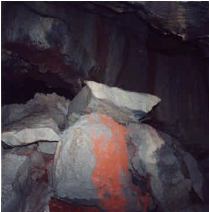
Fig. 10 - Cava Botte dell'Acqua. Esempio di crollo della volta, fenomeno frequente in tutta l'area di cava e che spesso occlude il passaggio. Si osserva un pezzo di lastrone lavico che era a contatto con la *ghiara* e le tracce di percolazione dell'acqua lungo le fessure della volta (foto di R. Bonaccorso).
